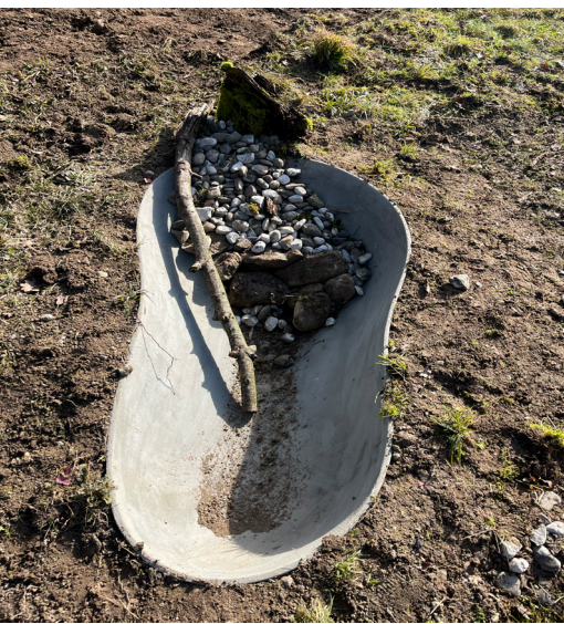
Fertig eingebaute Unkenwanne aus Eternit
